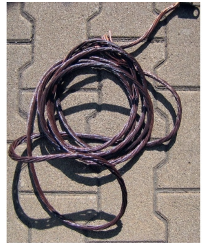
Bild 3. Auf der gesamten Länge durch Überhitzung oxidierte Schweißstromleitung.
