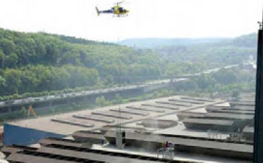
Per Hubschrauber wurden die Schalldämpfer auf dem Dach der Stranggießanlage montiert (Foto: Dirk Martin/Saarstahl)
